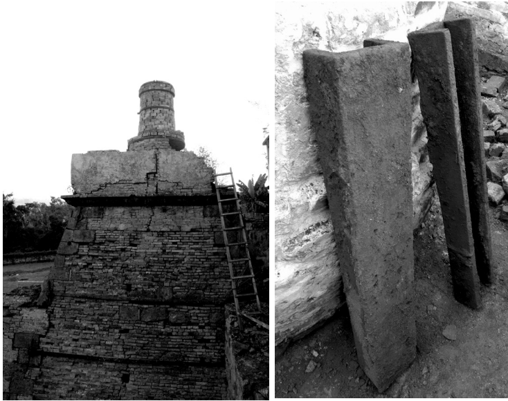
(Izq.) Vista lateral del alto horno, el segundo balcón desde donde se realizaba la carga está en el extremo de la escalera. (Der.) Canalones de hierro encontrados en el segundo balcón del horno. ©Roberto Lleras.
