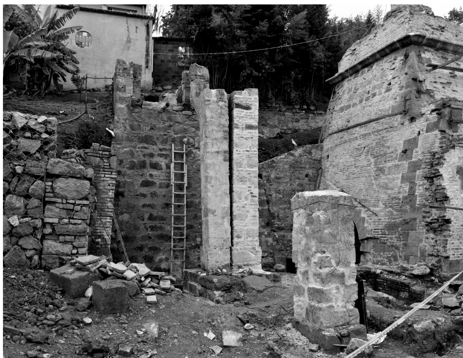
Estructura de la rueda de paletas. Pozo de descarga y machones que sostenían el eje de la rueda (centro). ©Sergio A. Díaz.
