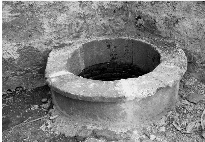
Pozo de salida del aire caliente de los túneles. ©Roberto Lleras.
