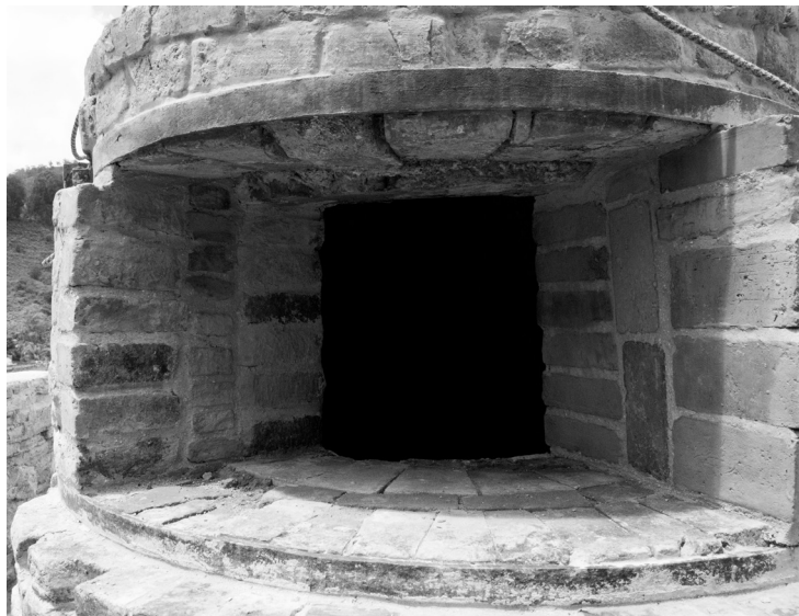
La boca de carga del horno. ©Sergio A. Díaz.
