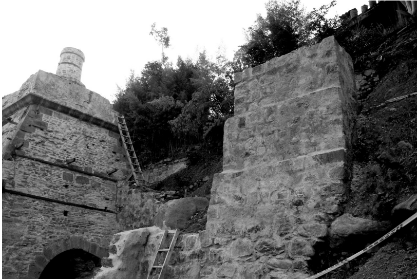
Machón (derecha) que sostenía una estructura lateral asociada con la carga del horno. ©Roberto Lleras.
