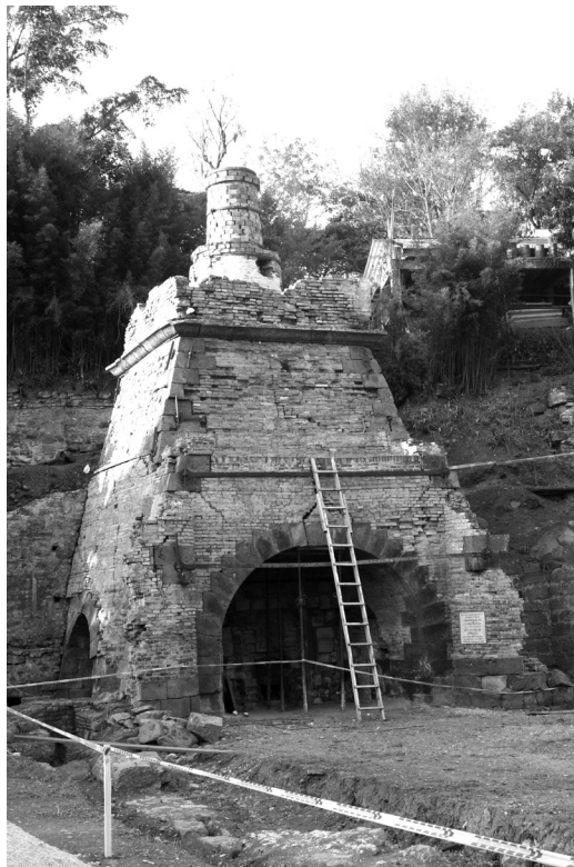
Fachada frontal del alto horno, el primer balcón está a la altura del extremo de la escalera. ©Roberto Lleras.
