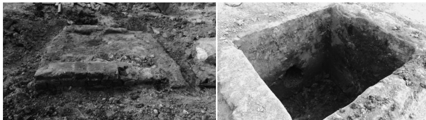
Caja de inspección; antes de excavar (izq.) y al terminar la excavación (der.).
