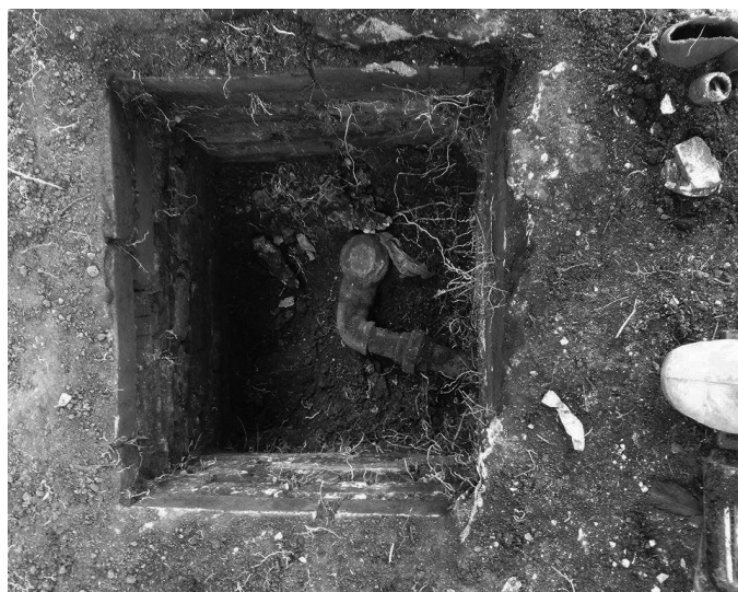
Levantamiento de adoquín, hallazgo de caja con tubería de gasolina a 20 cms. de profundidad
