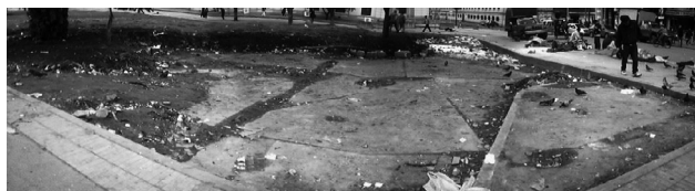
Remanentes de bordillos y placas de concreto del piso anterior.
